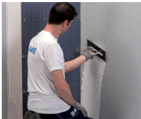
укладка настенного покрытия с применением Keraflex Maxi S1
