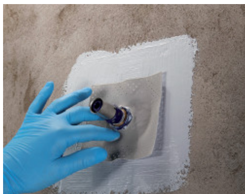
Приклеивание Mapeband PE 120 для сквозных отверстий с помощью Mapegum WPS
