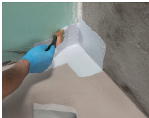
Приклеивание углового элемента Mapecband PE 120 90° с применением Mapegum WPS
