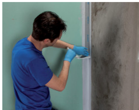
Приклеивание Mapecband PE 120 с применением Mapegum WPS
