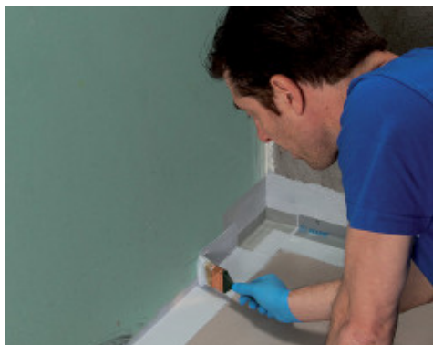
Приклеивание Mapecband PE 120 с применением Mapegum WPS
