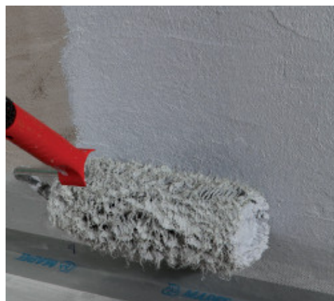
Нанесение Mapegum WPS валиком
