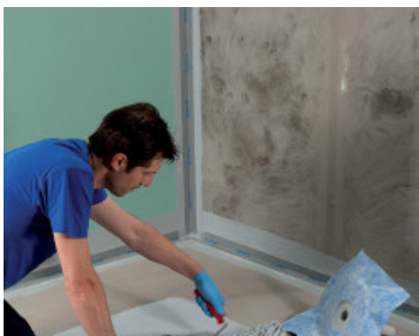
Приклеивание Drain Vertical с помощью Mapegum WPS
